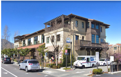
Tamalpais Commons Mill Valley, CA 40' height
